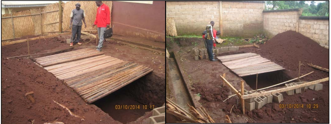
Implantation des soubassements avant la poursuite des excavations
