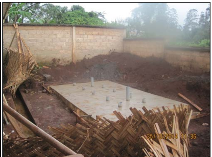
Dalle de la fosse à l'issue des excavations de 10m de profondeur
