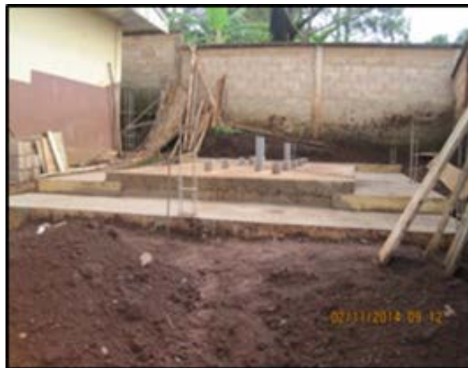
Toilettes à la fin des travaux de fondation
