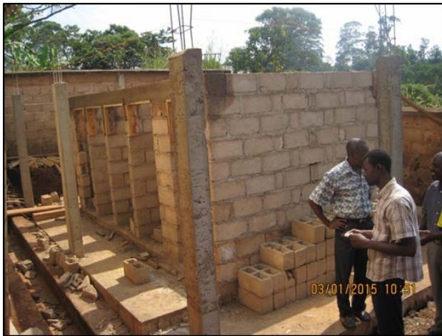
Elévation des murs en maçonnerie
