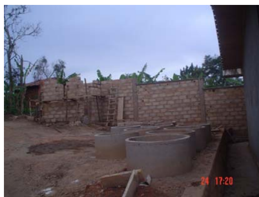
Une image de l'avancement des travaux de construction de la barrière et des buses pour le forage de l'école de Bandja
