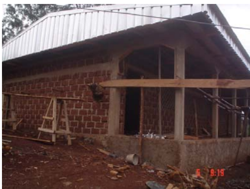
Un aspect des deux nouvelles salles de classe en construction à la Kinder's House de Banock en ce mois de mars
